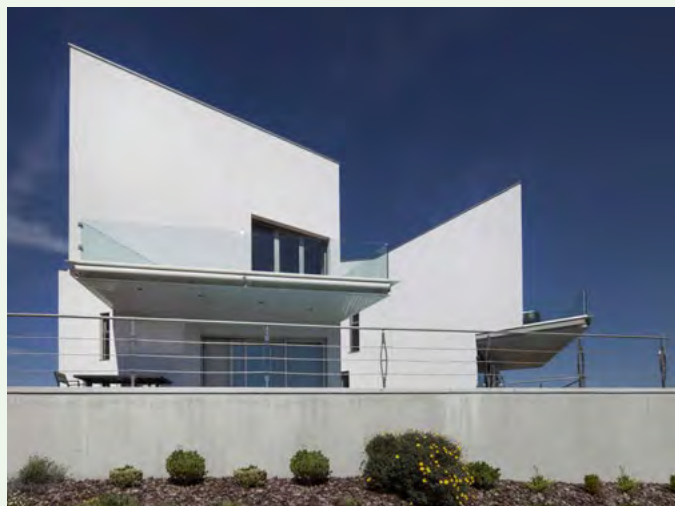
Vivienda en Las Rozas con fachadas de bloque Termoarcilla. Arq. Miror Arquitectos. Foto: Iraida Lombardía
