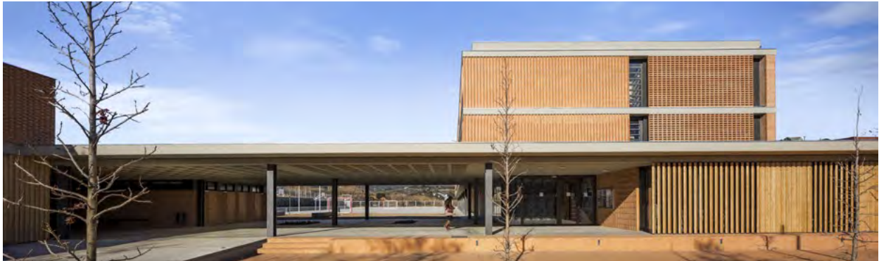
IES Les Almeriques en Terrassa Arq. Barceló Balanzó Arquitectes Foto: Simón García
