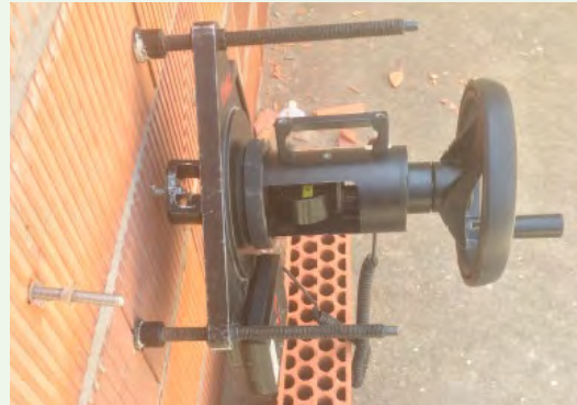
Ensayos de anclajes para fachada ventilada
