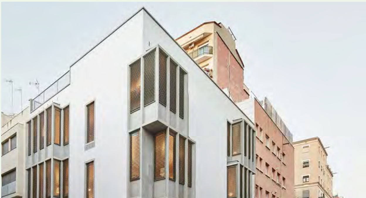
Bloque de viviendas en Barcelona, con cerramiento de bloque cerámico aligerado revestido con un sistema SATE. Arq. Raimon Farré Moretó. Foto: José Hevia
