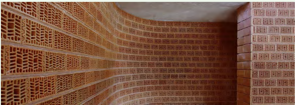
Pabellón multideporte con bloque Termoarcilla en Güevejar (Granada). Arq. Juan Moya Arquitectura
